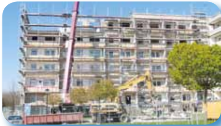
Teiltrückbau am Tierpark 17-19 in Staßfurt 2005
