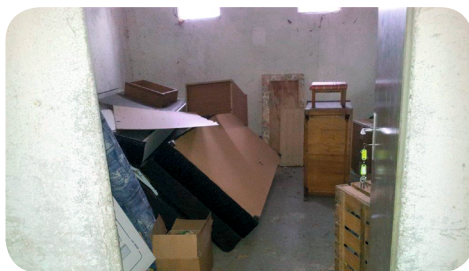
Ein eigentlich nicht benutzer, zugestellter Keller.
