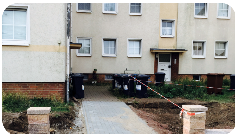
Concordiastraße während der Modernisierung
