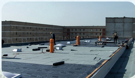
Arbeiten auf dem Dach.
