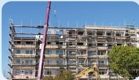
Teiltrückbau Tierpark 2005 mit Kran
