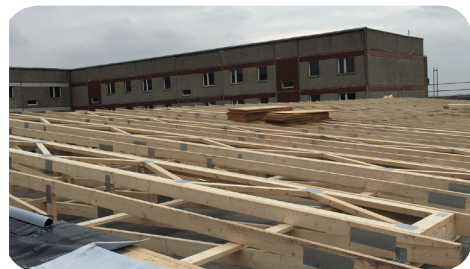
Blick auf den neuen Dachstuhl.
