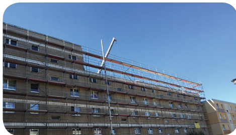
Einige Wohnungen sind schon zurückgebaut.
