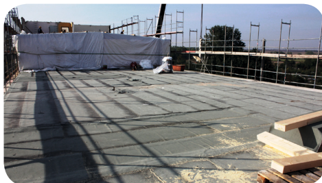
Beginn des Rückbaus auf dem Dach.
