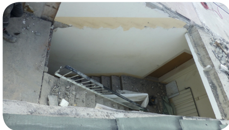
Blick auf freigelegtes Treppenhaus.
