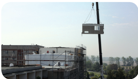
Wandteil des Flures am Kranhaken.
