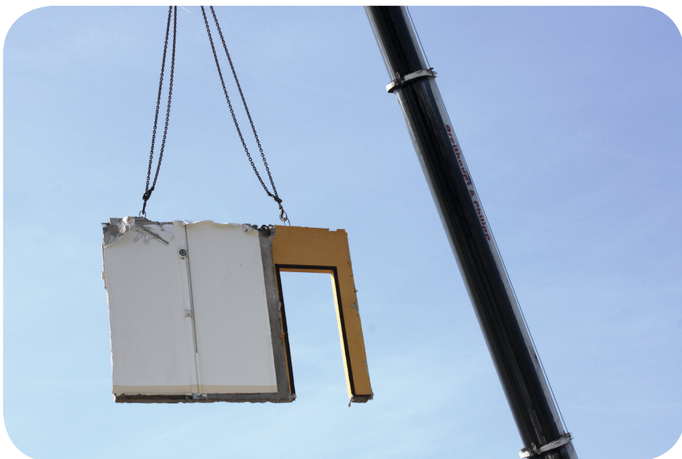
Abgetragenes Tür-Bauelement am Kranhaken
