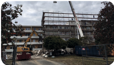
Direkter Blick auf die Baustelle.
