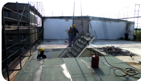
Entfernung eines Treppenelements.
