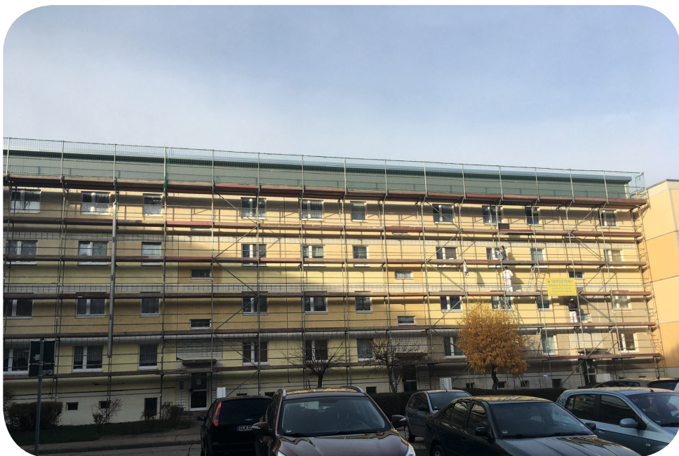
Neugestaltete Fassade mit Einrüstung in Staßfurt, Am Tierpark 25 – 29
