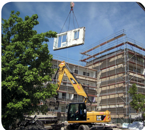
Entfernung eines Bauelements mit Kran
