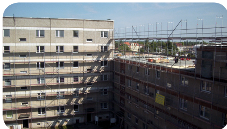
Blick auf die Einrüstung.
