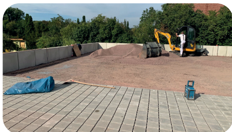
Die neue Parkplatzanlage Sülzestraße entsteht.
